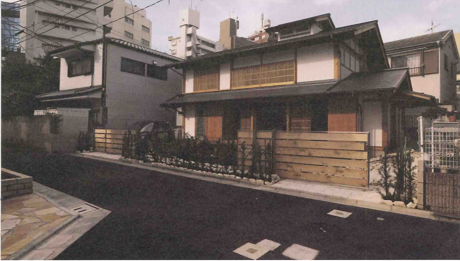
上*幅5.4メートル、高さ1.8メートルのYさんの家の格子戸。寸法は旅行中に見た秩父の酒屋の格子を参考に計らせてもらった。「格子は外と遮断されない方がいい」。家の中で、前を通り過ぎた子どもの「あ、昔の家がある」との声も聞こえたという 下*伝統工法で盛り上げたYさんの家は池袋駅の近く。道幅の関係でクレーンが使えなかったため、すべて人力で造った
