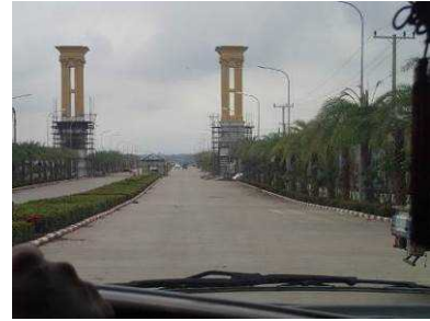
ODAなどにより急ピッチに進む道路インフラ整備
