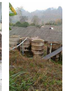
センター裏の貯水タンク
