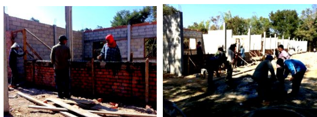
＜小学校建設に協力する村人＞(ラオスにて)
