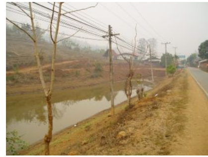
ワナルボン村での建設途中の溜め池
