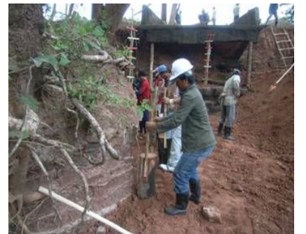
たこ締めによる土の締め固め状況
