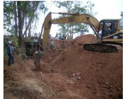
ローチョックによる作業
