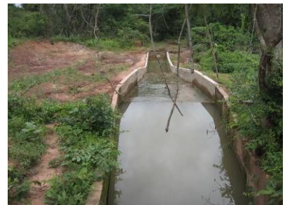
修復された水路
