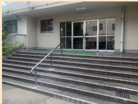
投票所として利用する「第五中学校体育館」の 出入りに手すりを設置*転倒事故を受け改善
