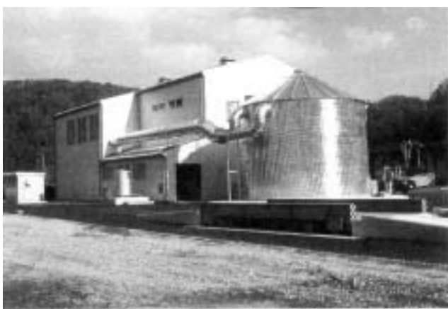
▲木質ペレット燃料製造施設
