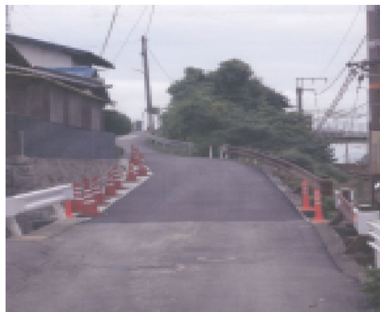
青木一丁目市道の側溝改良 側溝の「ふた掛け」がない為、道路幅が狭く危険な状態を改善(通学路)
