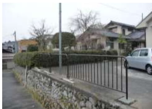
転落防止用の柵が設置される
