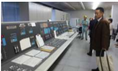
名古屋の排水機場の遠隔操作室
