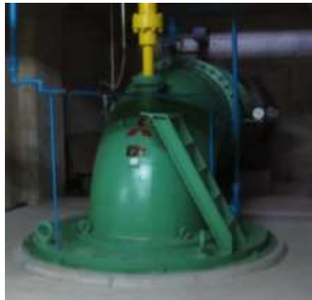
停止した排水機場のポンプ
