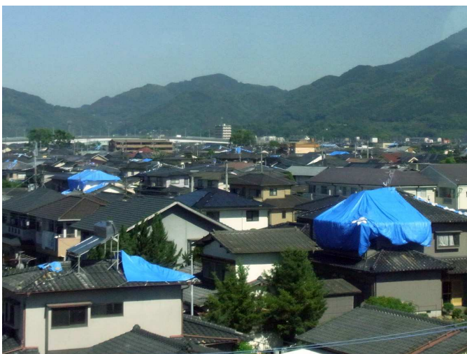
屋根にブルーシートを掛けている住宅（熊本県）
